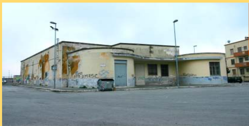
L'edificio dell'ex cinema Enal
