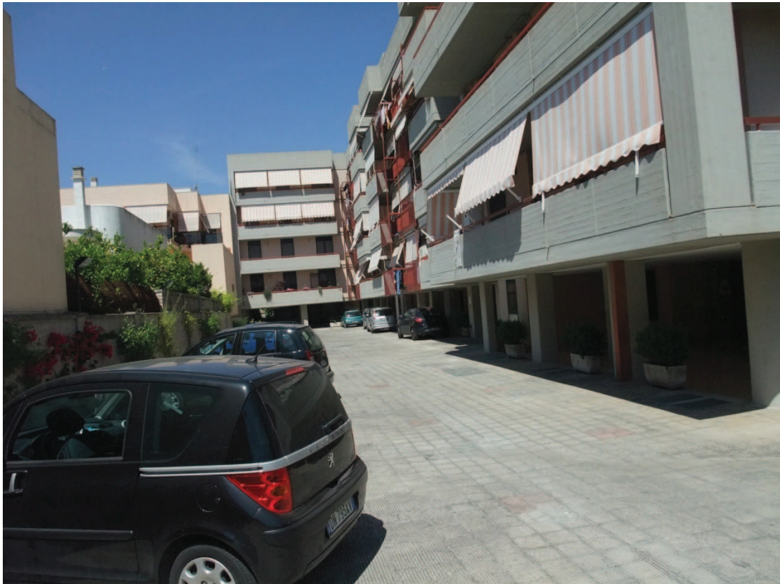
Area condominiale edificio su Via San Pietro
