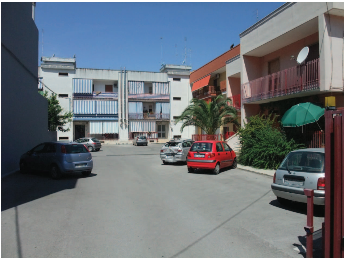
Area condominiale edificio su via San Pietro
