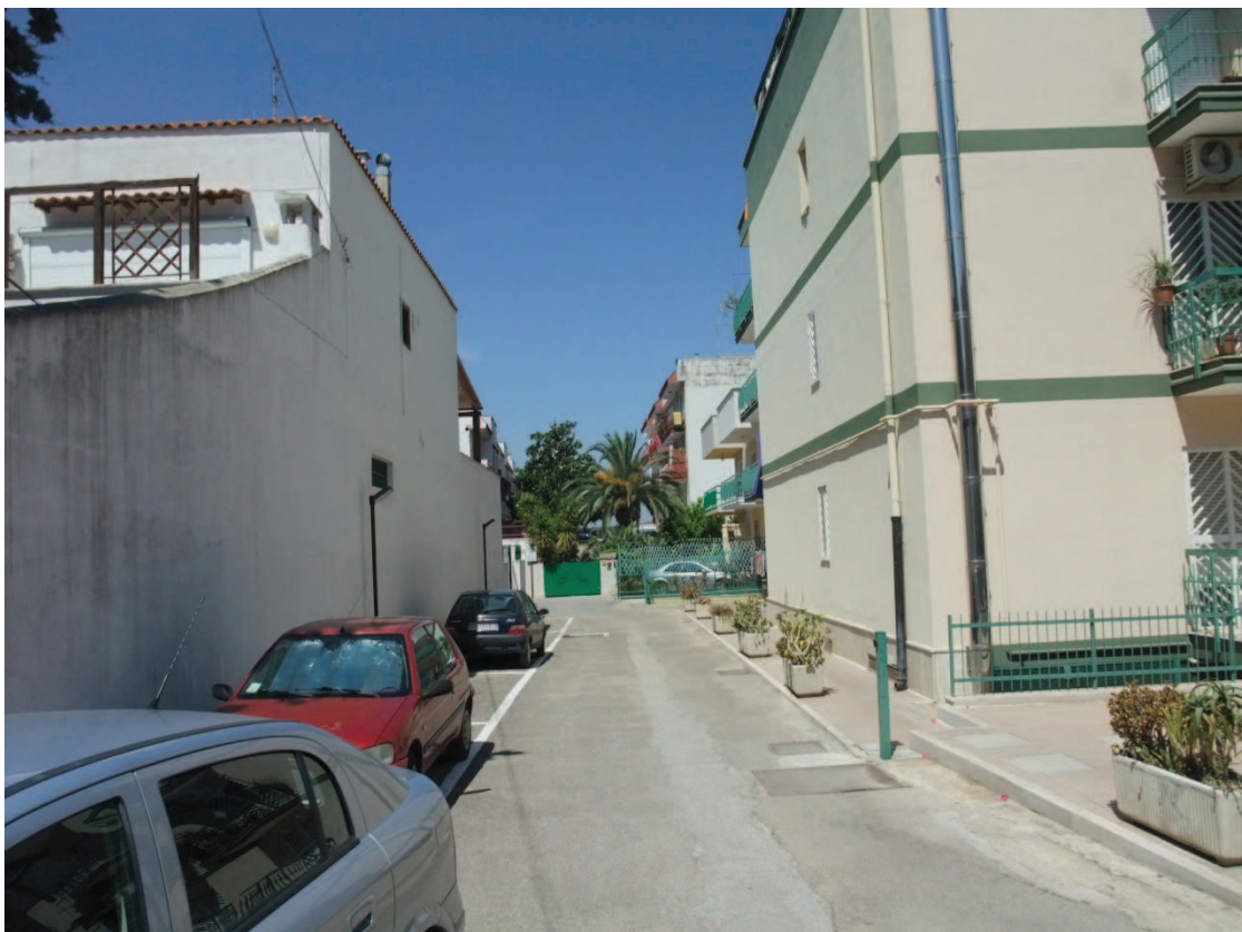
Area condominiale edificio su Via San Pietro
