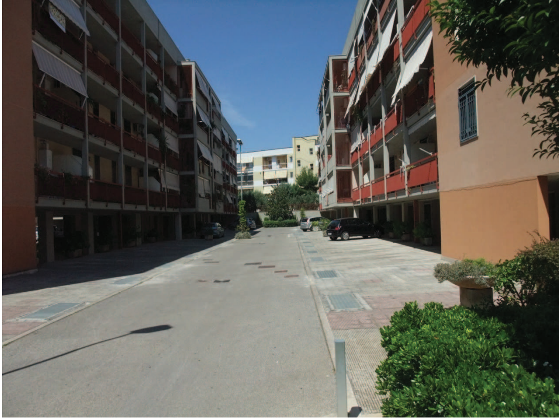
Area condominiale edificio su Via San Pietro
