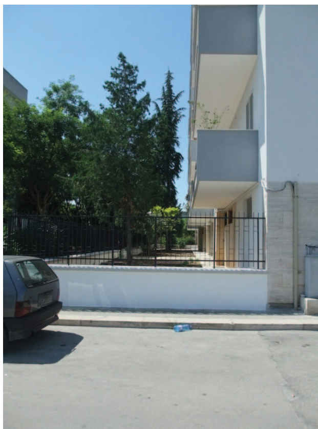
Area condominiale edificio su Via Francesco Petrarca
