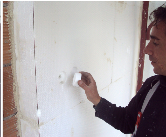
Posa in opera del tappo in polistirene a copertura del tassello
