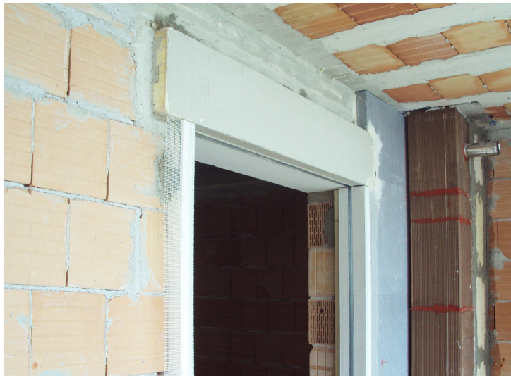
Posa in opera di cappotto, spallette e cassonetto coibentati
