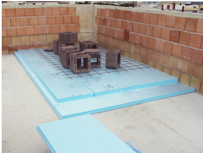
Posa in opera del doppio pannello in polistirene
