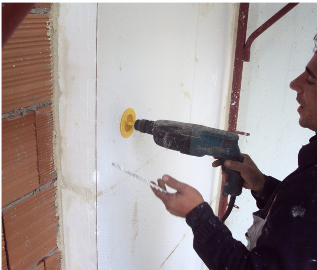
Posa in opera del cappotto con tassello in PVC
