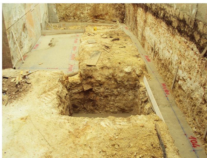
Scavo per la realizzazione della cisterna di raccolta delle acque meteoriche
