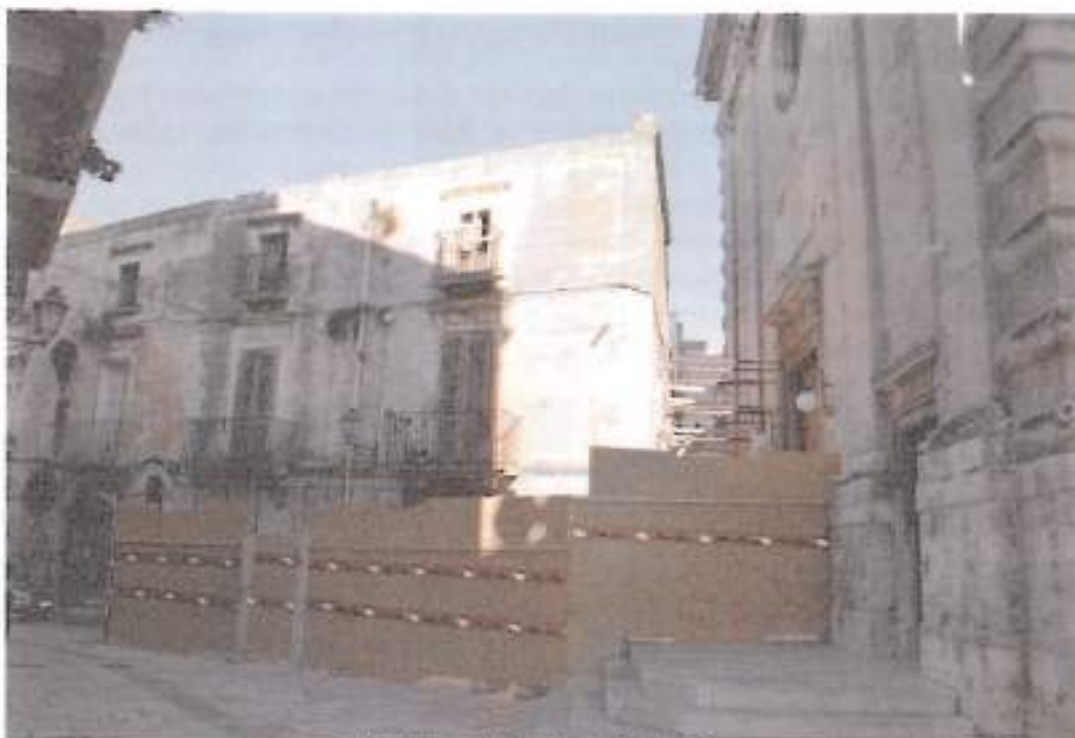
Vista della recinzione da via Regina Sforza
