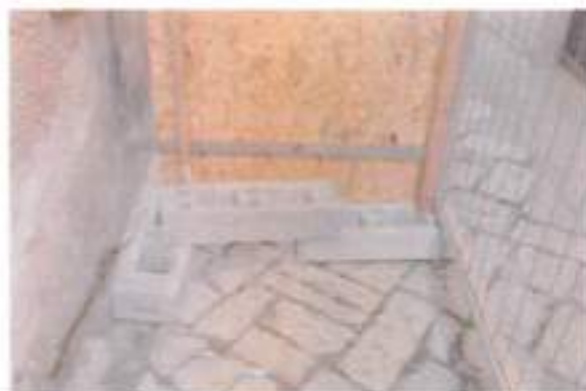
Blocchi di calcestruzzo di ancoraggio
