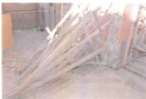
Puntellatura di legno dell'angolo del fabbricato
