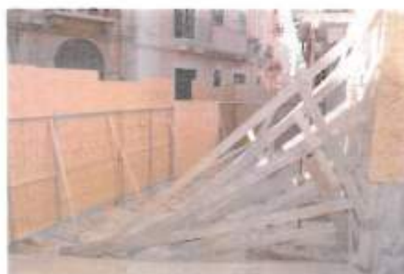
Puntellatura di legno dell'angolo del fabbricato
