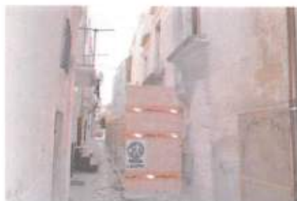
Vista della recinzione da vicolo Carone
