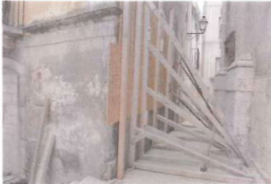
Puntellatura di legno tra il fabbricato e la Chiesa Madre
