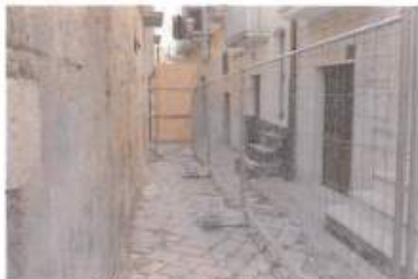
Recinzione metallica sul vicolo Carone
